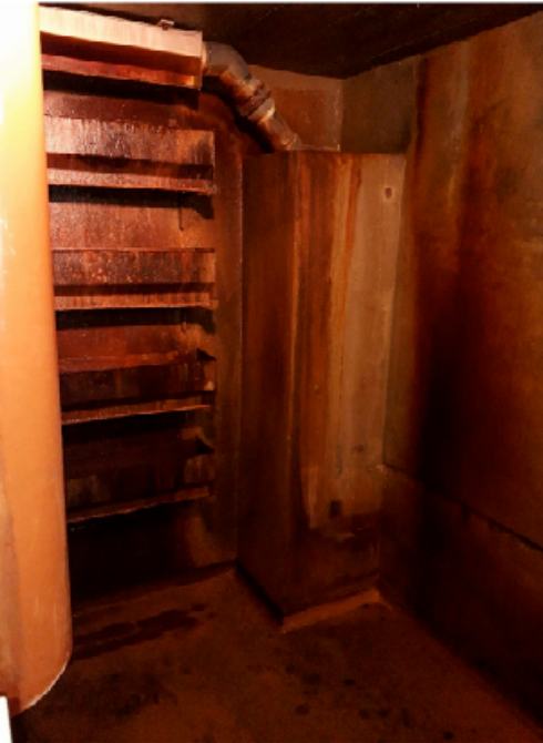
Nuværende beluftning (iltning)
